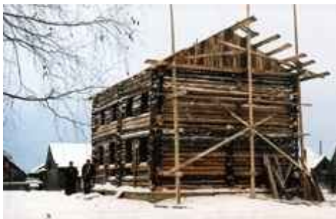
Строительство церковного дома
